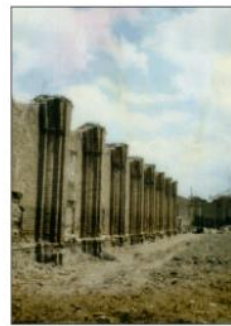
RESTOS DEL CLAUSTRO
